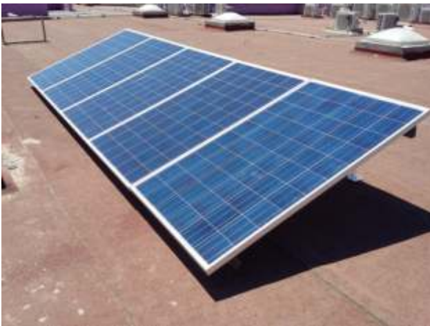
Figura 1. Módulos fotovoltaicos instalados [Autor].
